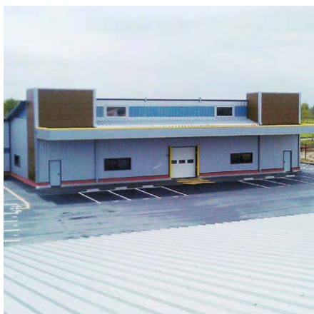
La Plate-forme de Distribution du Courrier de La Sauve est labellisée Très Haute Qualité Environnementale (THQE).
