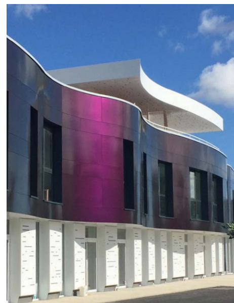
Les 300 m 2 de façade des nouveaux bureaux et de l'entrepôt Atlantic Design Construction France (33320 Eysines) se parent du ROCKPANEL Chameleon Violet/Vert/Bleu.
